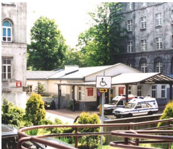
Zdjęcie nr 6. Łącznik pomiędzy budynkami "A" i "B"
