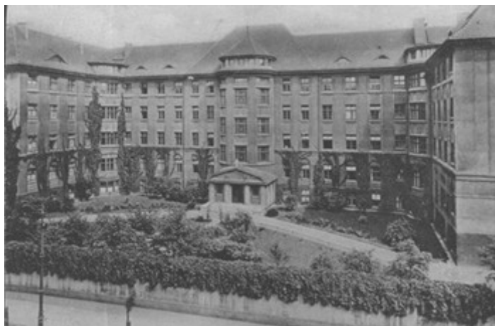
Zdjęcie nr 5. Obecnie budynek "A", najmłodszy i najlepiej zachowany z gmachów, zdjęcie z roku 1938
