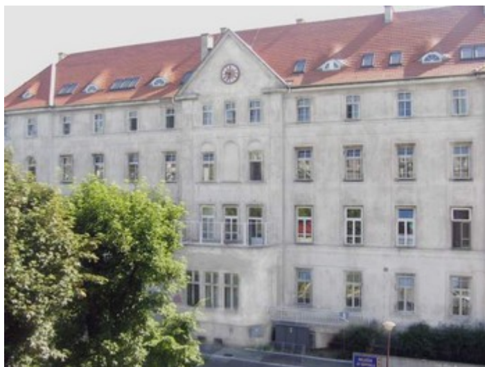
Zdjęcie nr 9. Budynek "B" z zamontowanym zegarem zewnętrznym.
