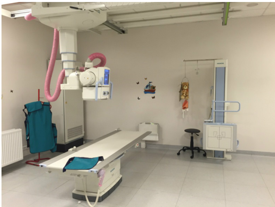
4) 3 przewoźne aparaty RTG
