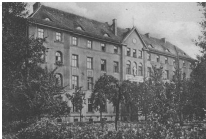
Zdjęcie nr 3. Obecny budynek "B", w którym mieszczą się oddziały dziecięce, zdjęcie z roku 1938
