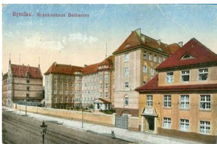
Zdjęcie nr 4. Widok od ul. Traugutta, od prawej obecny budynek "D", w którym mieszczą się Apteka szpitalna, Dział Higieny i Epidemiologii, oraz Pracownia Laboratorium Mikrobiologicznego; budynek "A", oraz budynek "C" dyrekcji szpitala. Poczтівka lata 1900-1945
