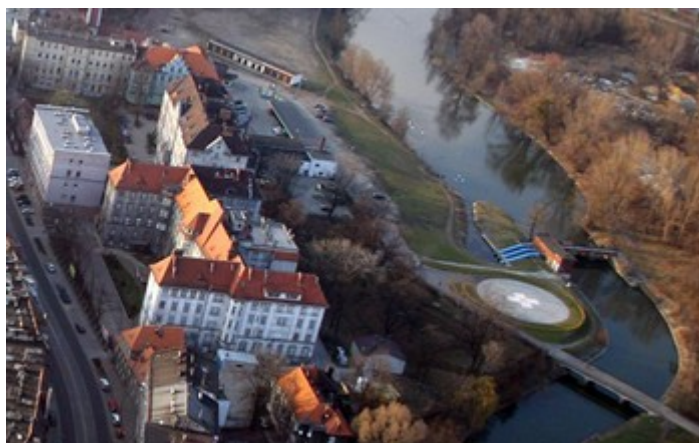
Zdjęcie nr 7. Szpital z lotu ptaka. Lądowisko dla helikopterów
